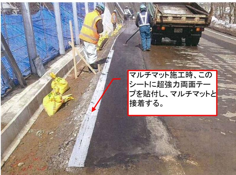
マルチマット施工時、このシートに超強力両面テープを貼付し、マルチマットと接着する。
