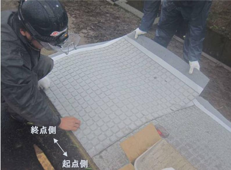
一枚目のマルチマットのシート余長に貼付してある防水性超強力両面テープの養生紙を剥がします。
