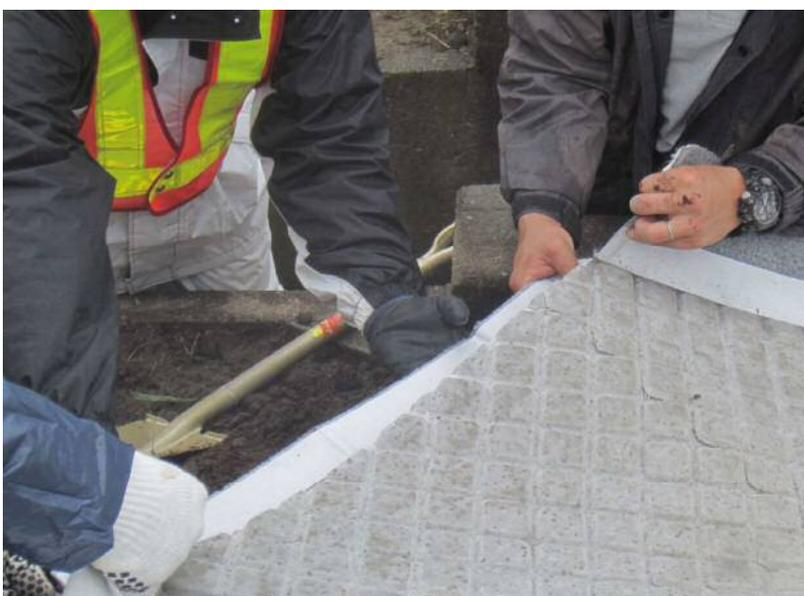
ジョイントテープの養生紙を一行分だけ剥がし、マルチマット切断部裏面に貼付します。
