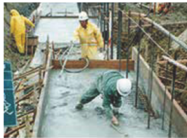
⑤ 縦貫コンクリート打設
