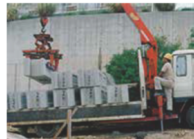
⑥ ゴールコン上段設置・打設
