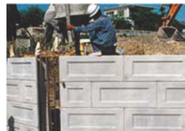
⑥ ゴールコン上段設置・打設
