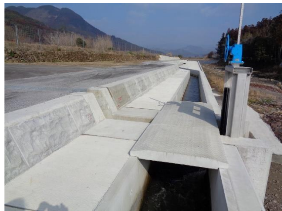
高水敷のサンエスハツリ・FT フリューム
