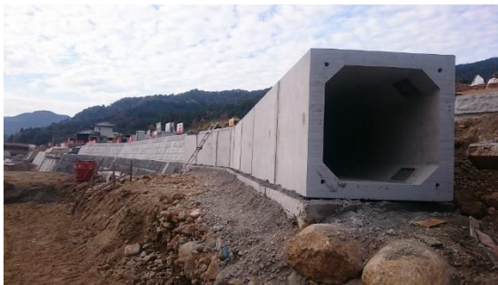
施工中のボックスカルバート
