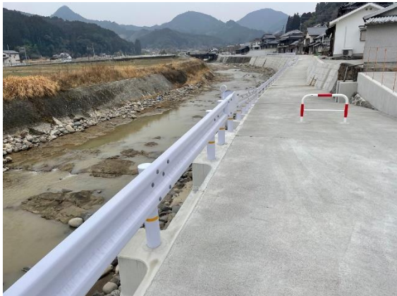
護岸天端部ガードレール基礎のプレガードⅡ
