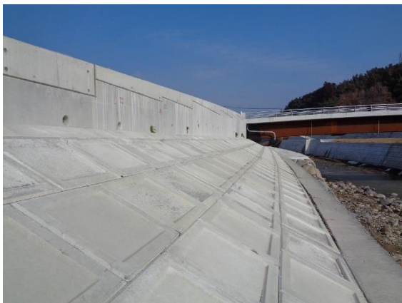
GTRウォール・N張ブロック（下流側）
