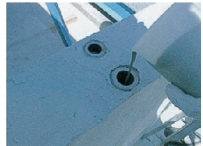
YPJマテリアル注入状況
