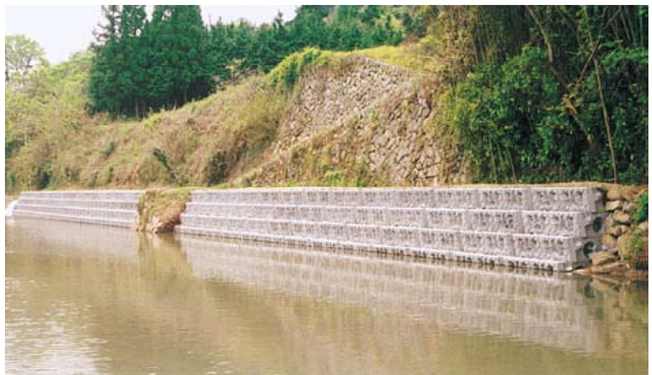
カゴボックス多段積みタイプ 公共災害復旧工事(加茂川)
